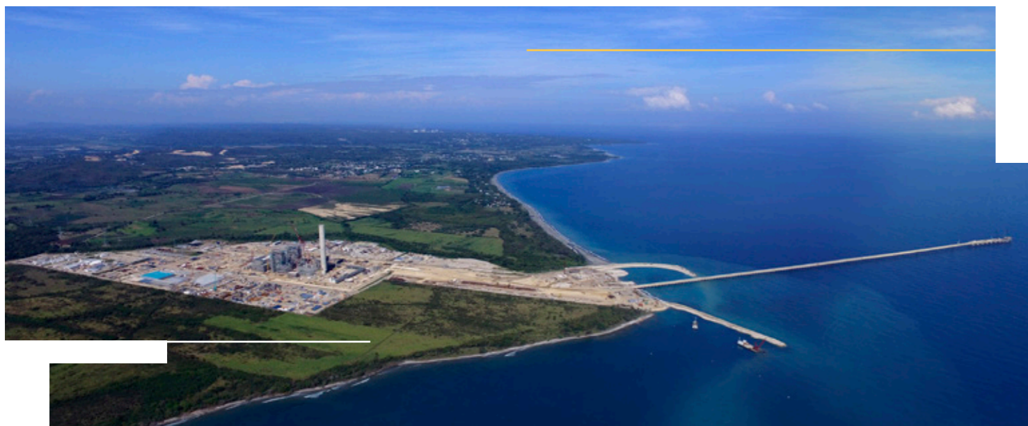
A Central Termoeletrica de Punta Catalina é o projeto mais relevante para geração de energia na República Dominicana
