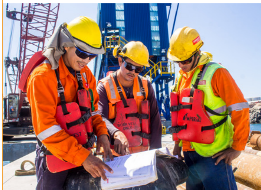
No Porto de Matarani, no Peru, Integrantes da Odebrecht Engenharia & Construção – Infraestrutura atentam para as normas de segurança nas operações
