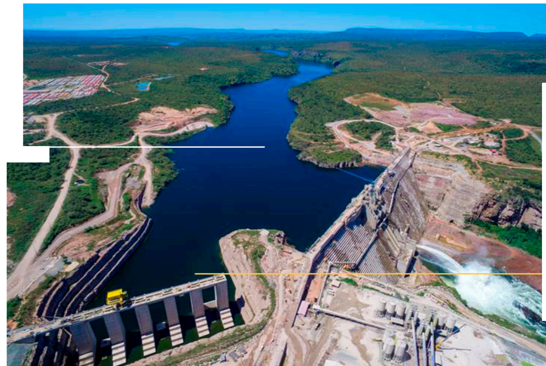
Cerca de 8,5 mil integrantes participam da construção da Hidrelétrica de Laúca, em Angola
