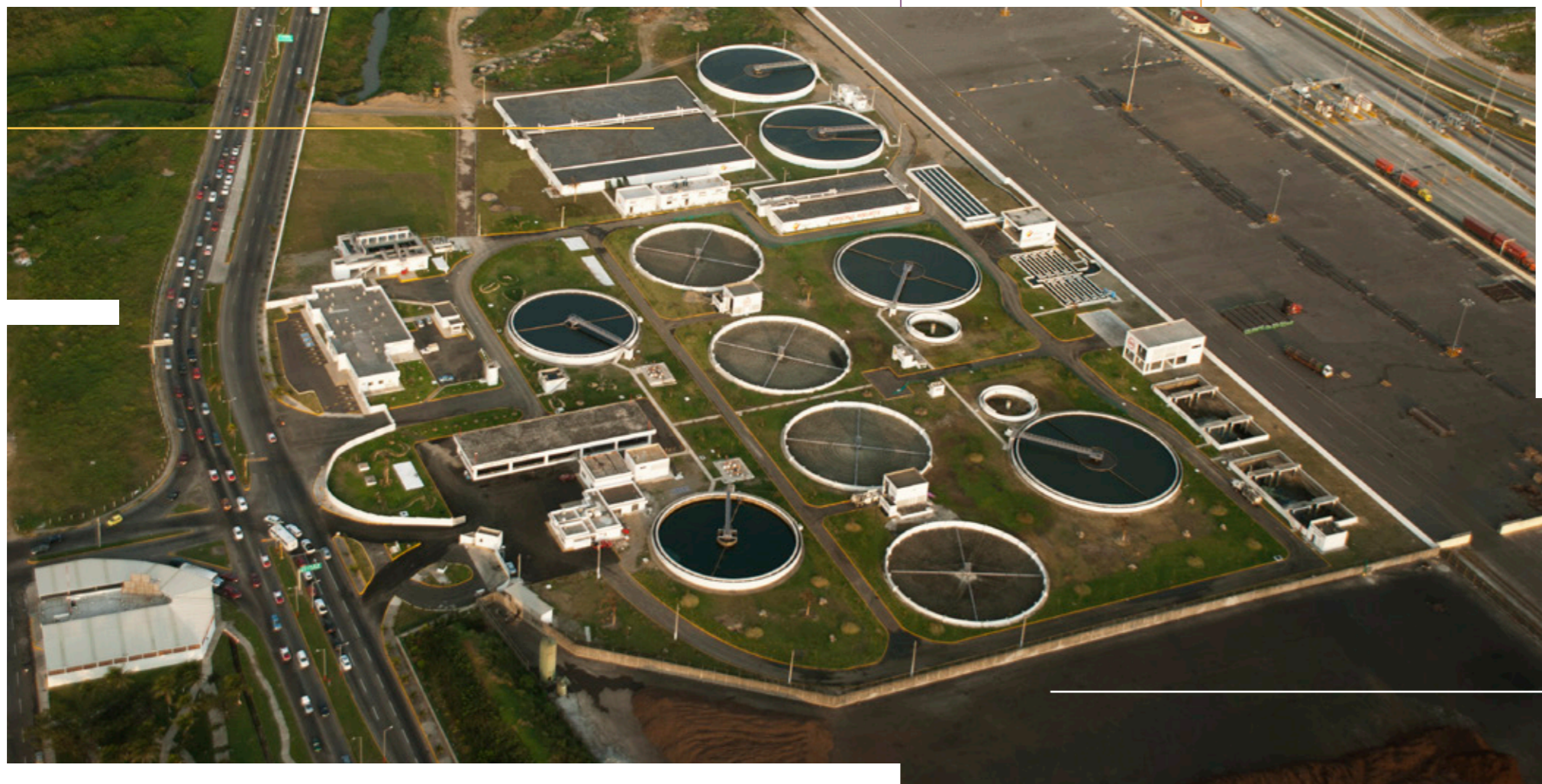
A Estação de Tratamento de Esgoto (ETE) Norte, na cidade de Veracruz, no México
